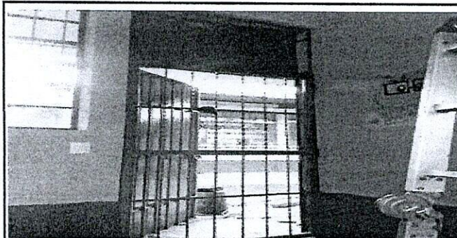
Foto 5: colocacion de la puerta
